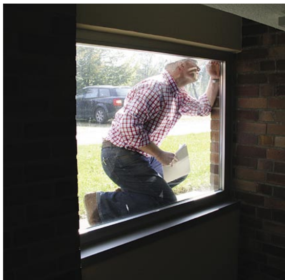
Ein bisschen Sherlock Holmes muss jeder Energieberater sein. Die Suche nach den richtigen Daten, wie hier dem U-Wert der Fenster, ist häufig Detektivarbeit
