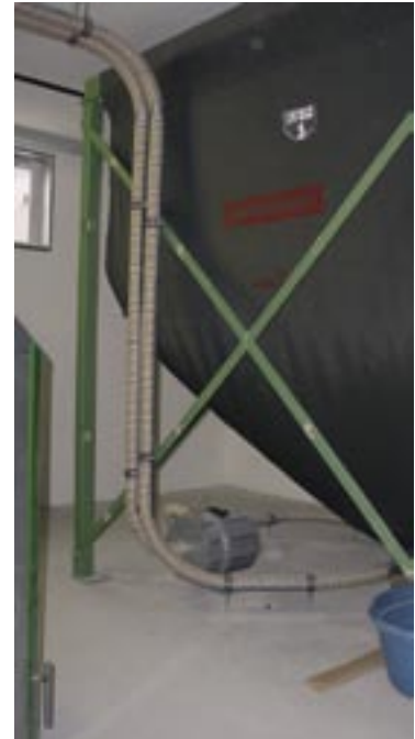
Als Pelletlager können auch Sacksilos verwendet werden
