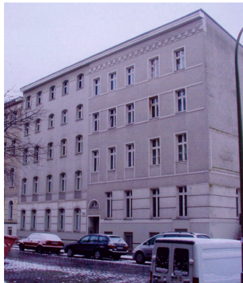
Bild 2: Mehrfamilienhaus des Praxistests
